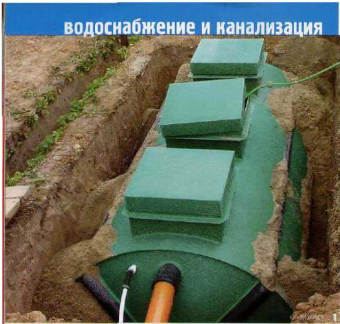
1. Четырёхступенчатая система глубокой биологической очистки сточных вод «Лидер» с корпусом, который выполнен из полиэтилена низкого давления. Стоимость оборудования для семьи из четырёх-пяти человек составляет \$ 2890
